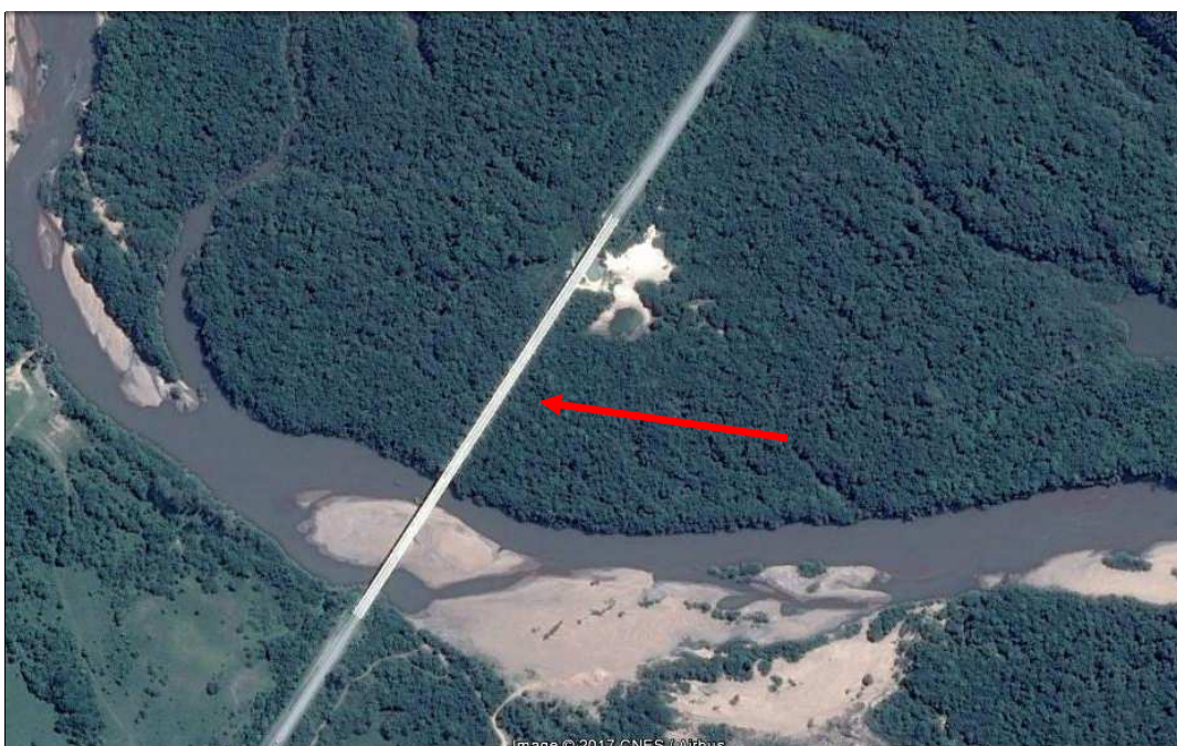
Figura 1: Localização geral da obra (ver seta)
