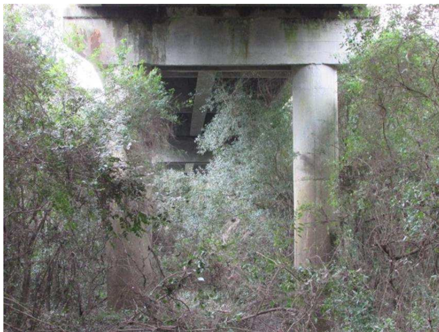
Foto 31 Vista da face Sul da linha de apoio 7 da OAE.
