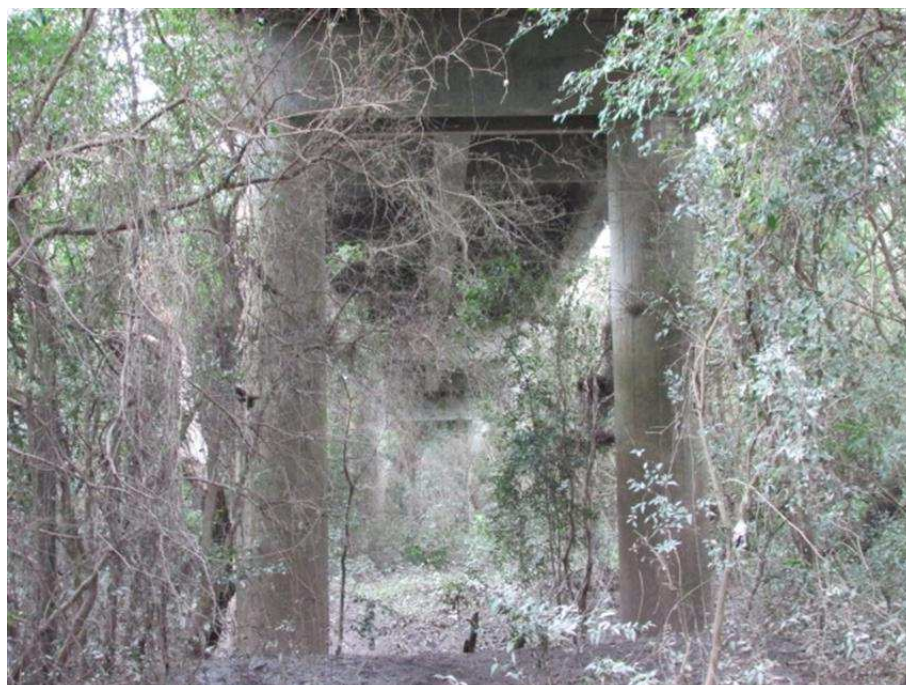
Foto 32 Linha de apoio 9 – face Sul.
